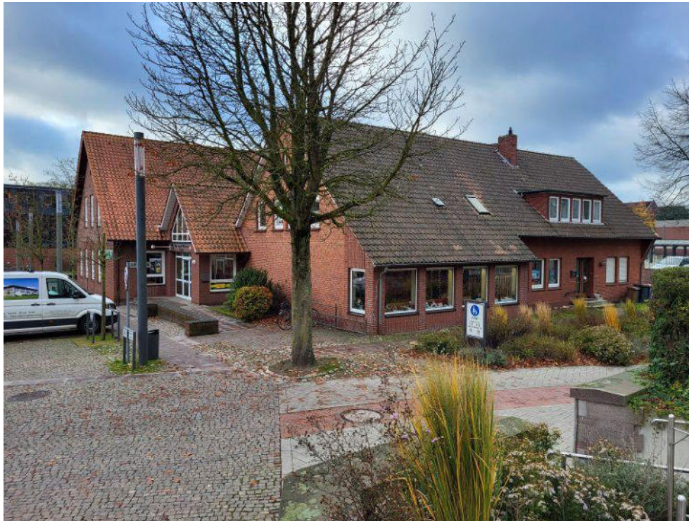
Foto 1: Blick von Nordosten auf den Gebäudekomplex
