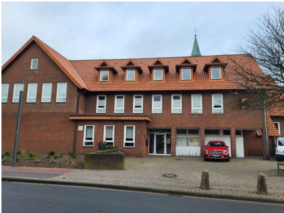
Foto 2: Blick von Süden auf den Gebäudekomplex
